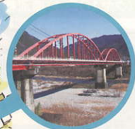
中部大橋(B型鉄橋)
